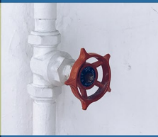
Pemeliharaan sistem instalasi pipa
